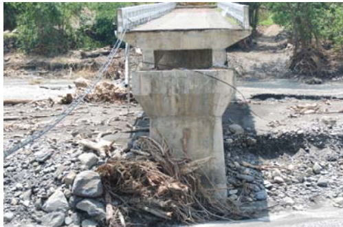
圖 1 水災後橋下漂流物、土石淤積情形
